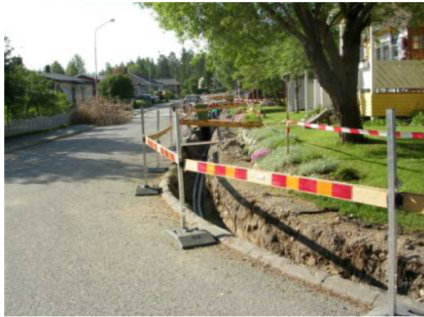
Kuva 3.2. Kaivuutöiden järjestelyitä Ruotsissa 8 .
