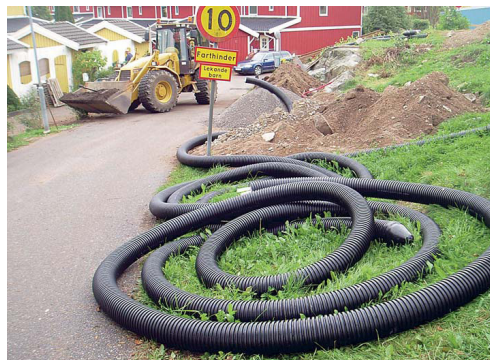
Kuva 1.1. Kaukolämpömuoviputken asennustöitä Ruotsissa 1 .
